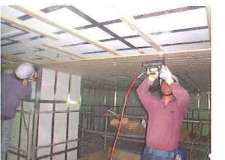
収蔵庫の施工状況
