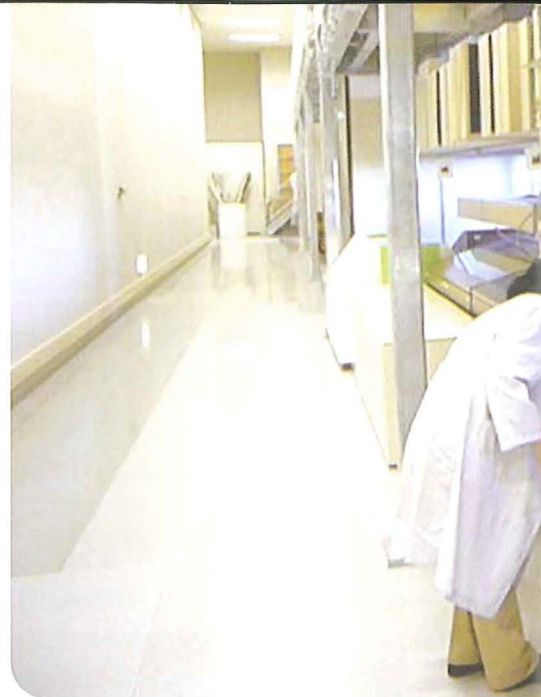
改修後のバックヤード(下層)棚の下は免震台専用収納スペース。ハンドリフトで作業できる高さを計算した。
