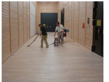
収蔵庫前室兼通路メンテナンス
