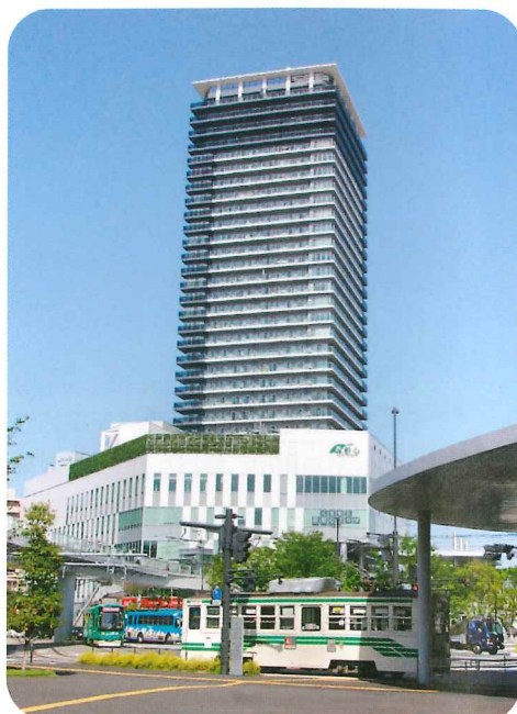
くまもと森都心プラザ全景
