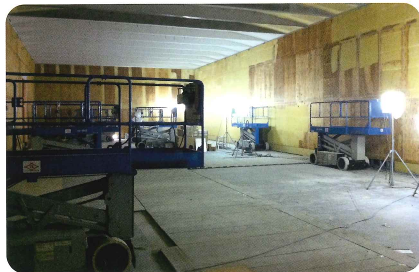
新展示室 工事風景
