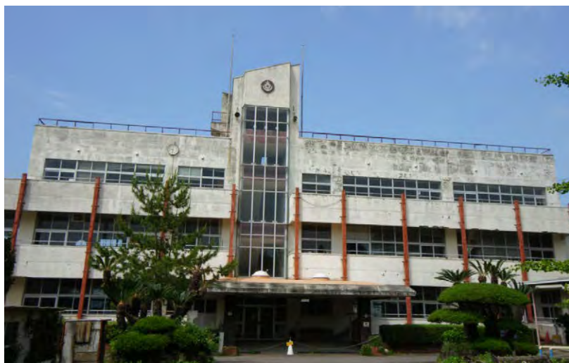
旧津奈木町立赤崎小学校
