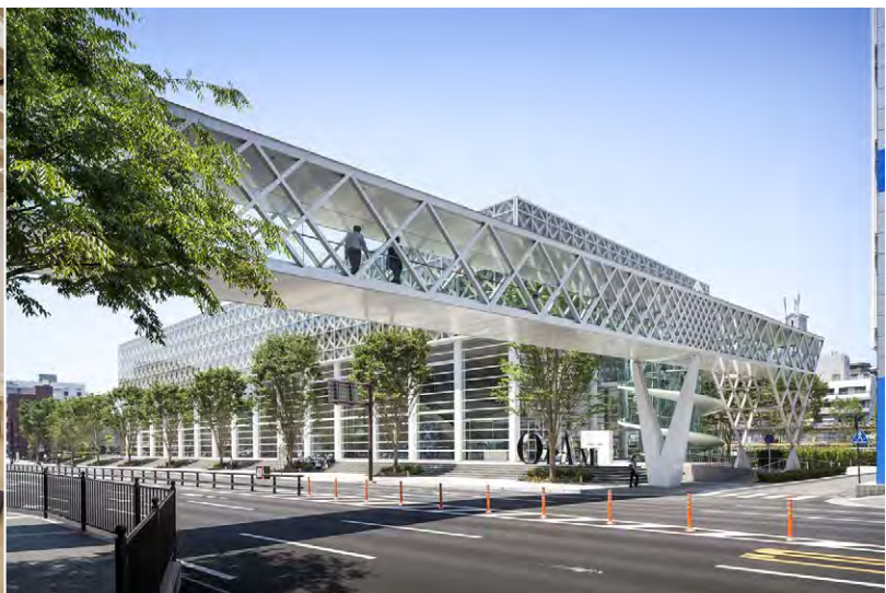
ペDESTリアンデッキ ©Hiroyuki Hirai
