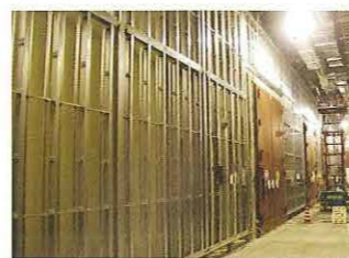
建設中の収蔵庫
