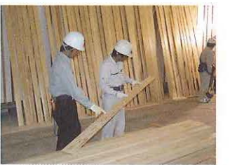
現場での受入れ検査【写真3】
