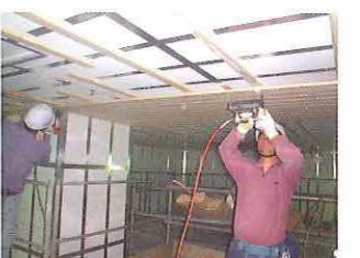
収蔵庫の施工状況
