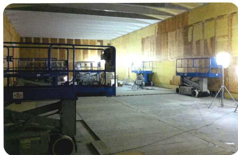
新展示室 工事風景
