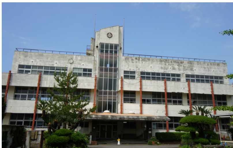
旧津奈木町立赤崎小学校
