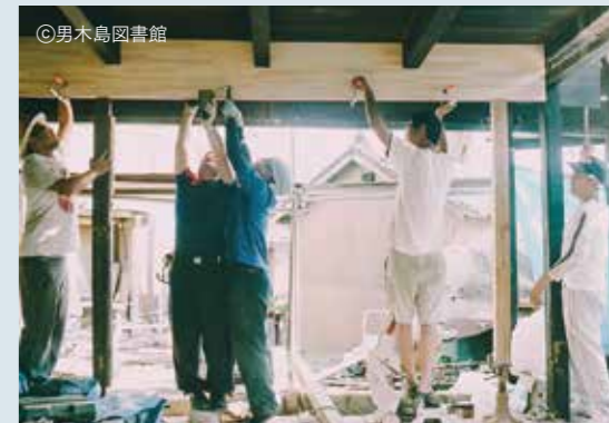
©男木島図書館 改修作業の様子
